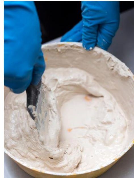
آماده کردن خمیر گچ کاری
